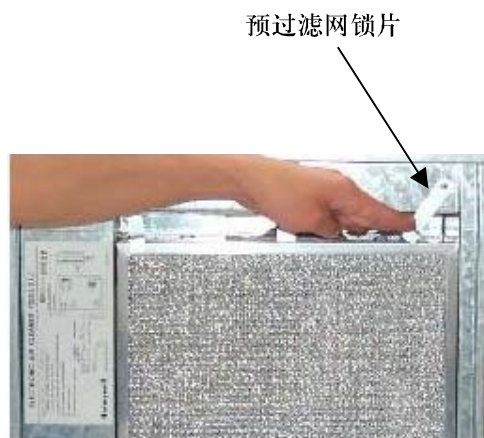
图13. 用锁片固定预过滤网
