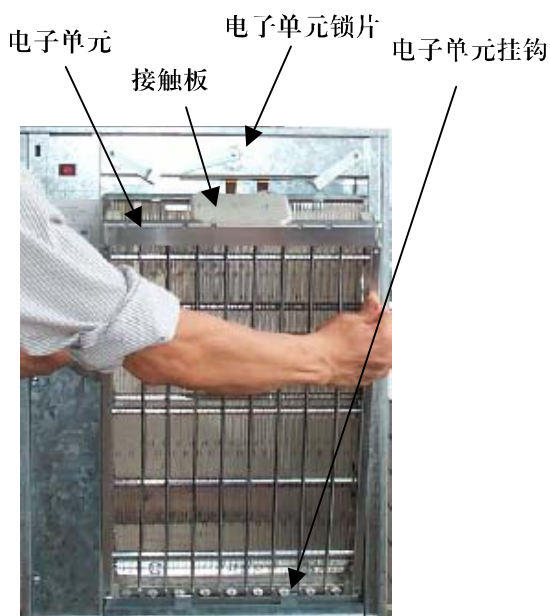
图11. 确认挂钩已钩住电子单元边框
